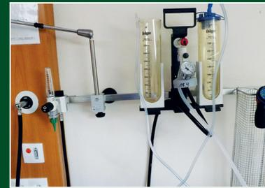
An jedem Bett befindet sich eine Medienleiste mit Anschlüssen an die zentrale Sauerstoff- und Druckluftversorgung sowie eine Anzahl von elektrischen Anschlüssen. Zugleich ist an jedem Bett eine separate Arbeitsbeleuchtung installiert. Jedes Bett ist von 3 Seiten zugänglich. An den Fußenden der Betten sind ausziehbare Ablagen, z. B. für das Lagern bestimmter Materialien.
